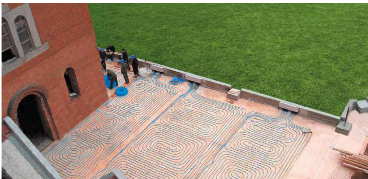
Rys. 5. Instalacja podgrzewania zewnętrznego tarasu przy wykorzystaniu rur bluePERT systemu KAN-therm.
